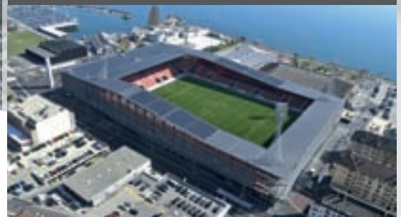
Stadion La Maladière, Neuchâtel
