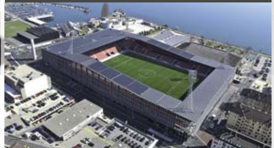
Stadion La Maladière, Neuchâtel
