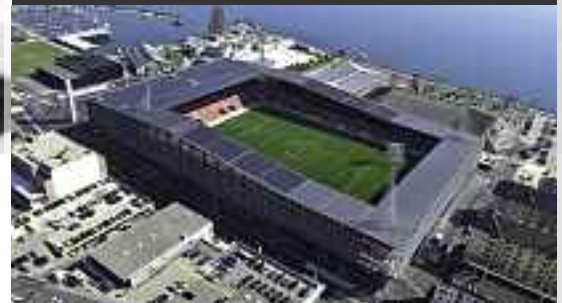
Stadion La Maladière, Neuchâtel
