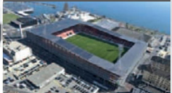
Stadion La Maladière, Neuchâtel
